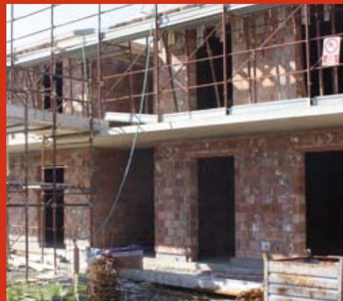
Realizzazioni di murature con malta termoisolante a base di argilla espansa.
