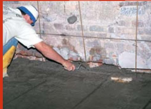
Consolidamento di un solaio in legno con calcestruzzo leggero strutturale.
